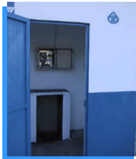
FIG.-3.-EQUIPO DATA LOGGER EN LA ESTACION PTO. DE HIERRO
