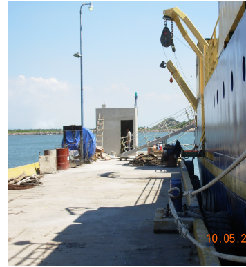
MAZATLAN, SIN. CASETA MAREOGRAFICA RECONSTRUIDA
