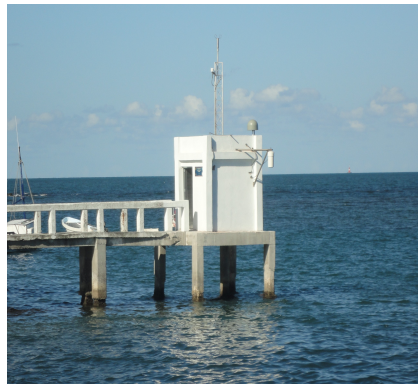
VERACRUZ, VER. CASETA MAREOGRAFICA RECONSTRUIDA Y EQUIPADA CON SENSORES DEL NIVEL DEL MAR REDUNDANTES, METEOROLÓGICOS Y GPS DE ALTA PRECISIÓN
